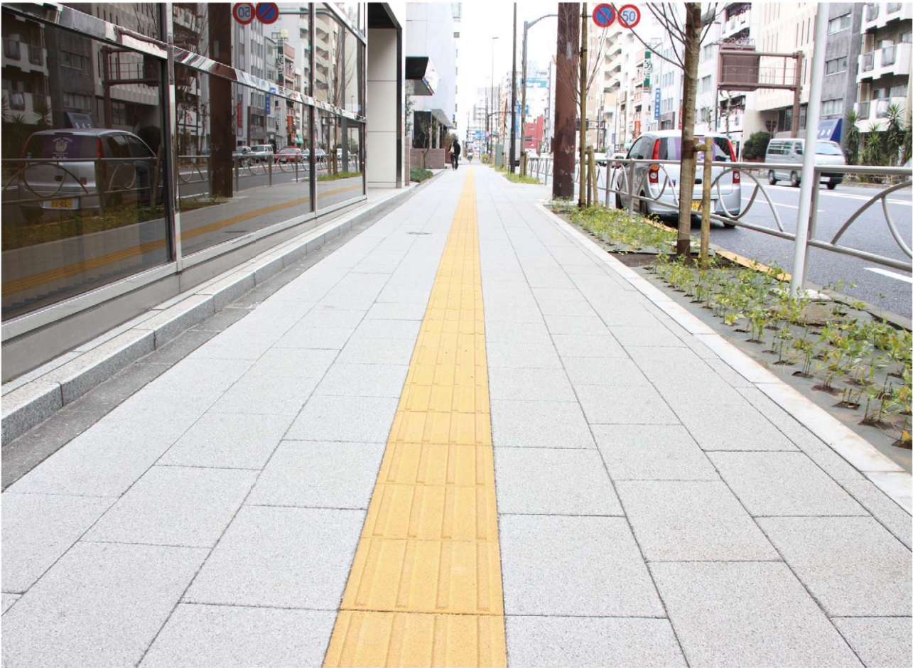
東池袋歩道：通行量の多い都心エリアに使用されたミマーレ Pシリーズの舗装例。明るいカラーセレクトは、誘導ブロックとも自然に融和しています。
